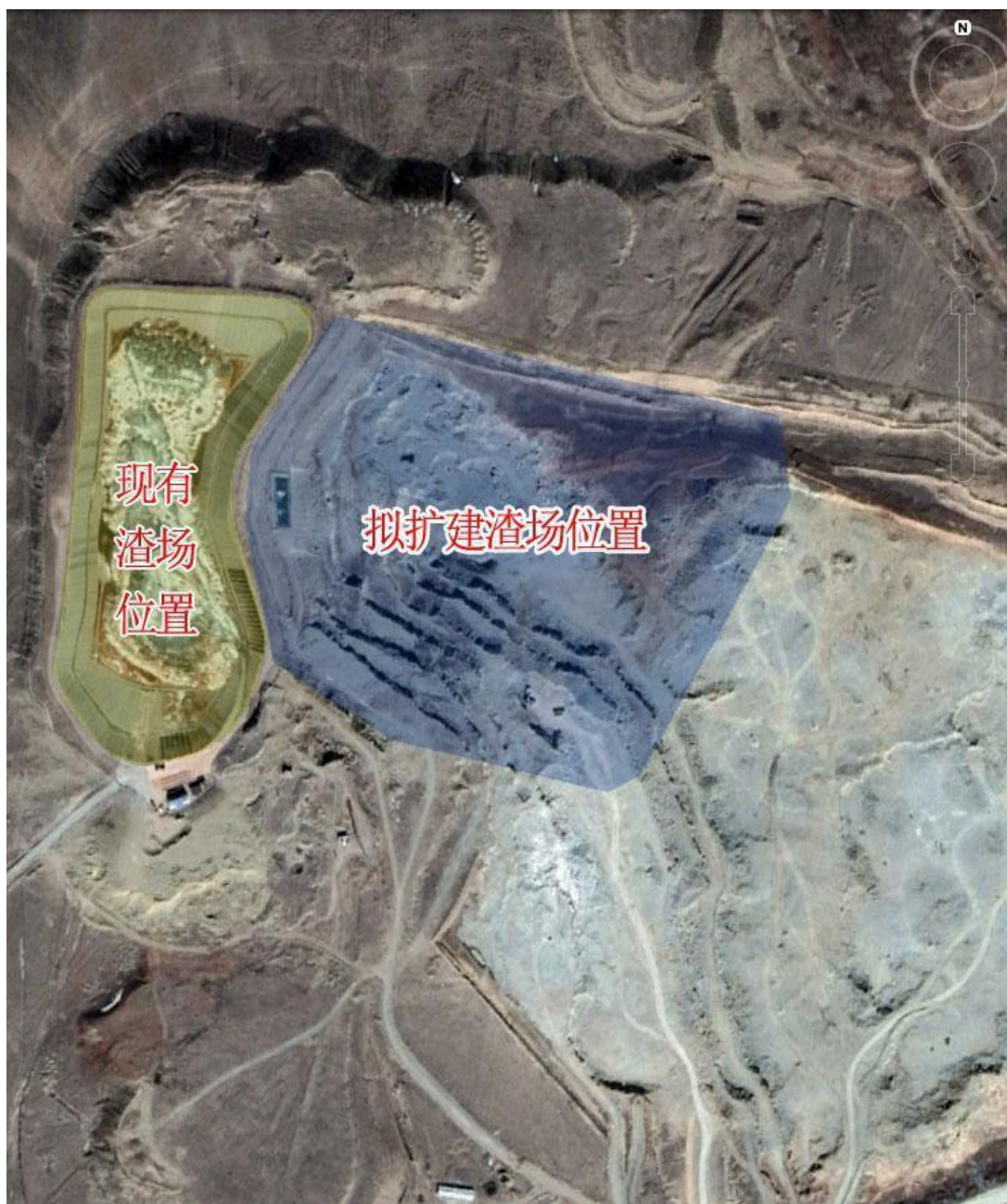
呼伦贝尔经济开发区有色冶炼渣场工程卫星图
