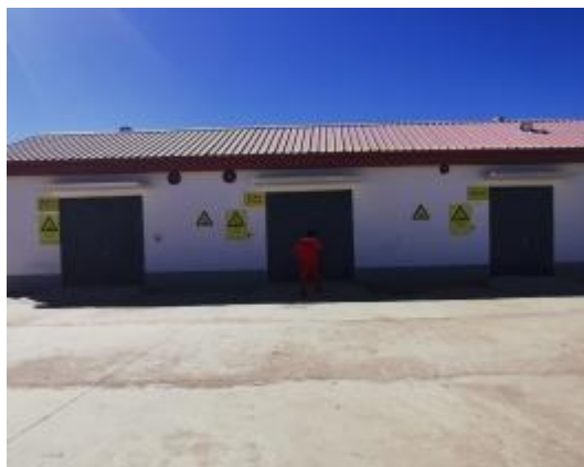
危险废物暂存库厂房
