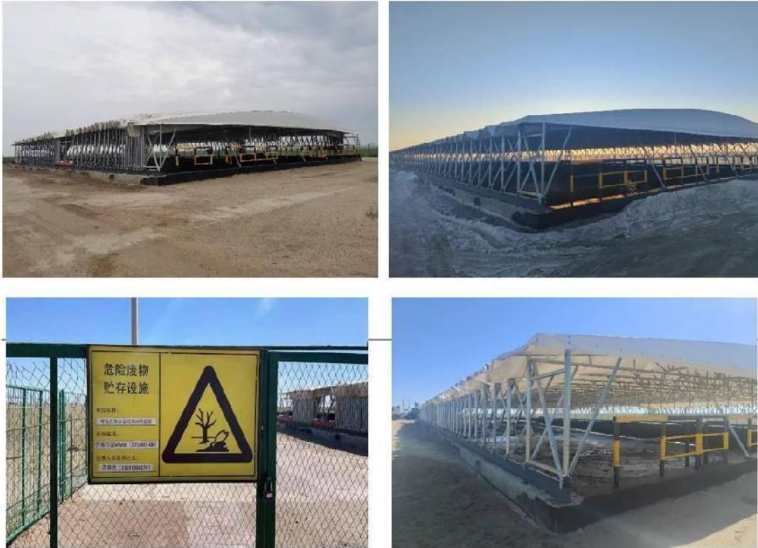
图 3.1-3 贝 28 作业区含油污泥暂存池现状照片
