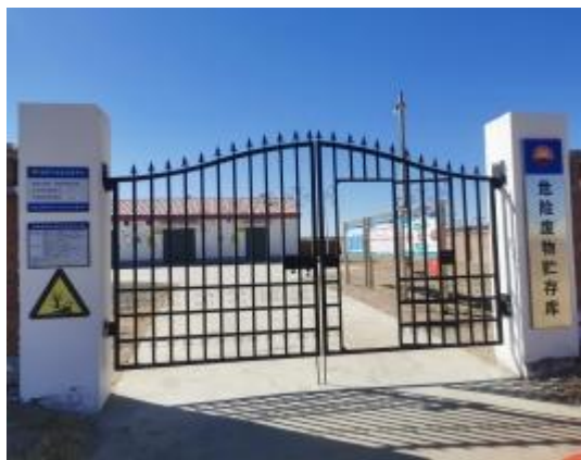
危险废物暂存库大门
