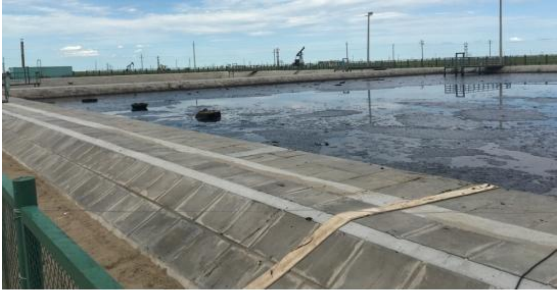
图 3.2-14 压裂返排液处理站现状照片（拍摄时间：2024 年 4 月）
