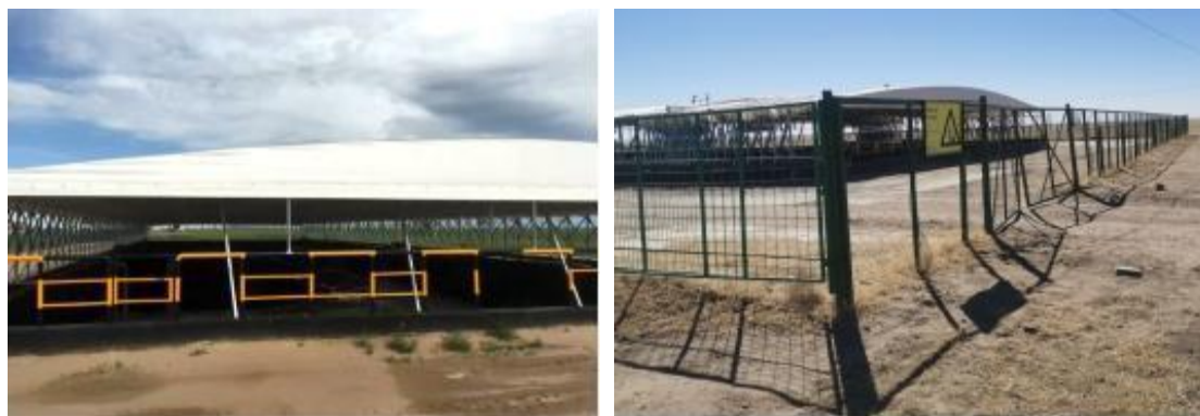
图 3.2-11 含油污泥暂存池现状照片（拍摄时间：2024 年 4 月）
