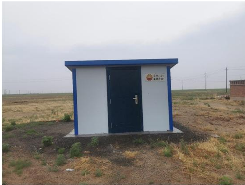
图 3.1-6 跟踪监测井现状照片
