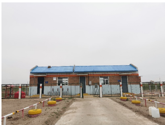
阀组间进站道路
