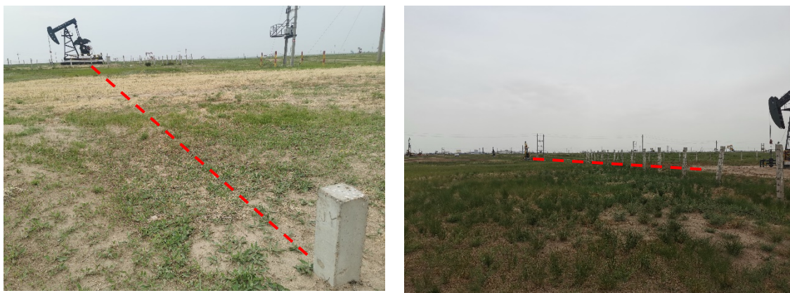
管线植被恢复
