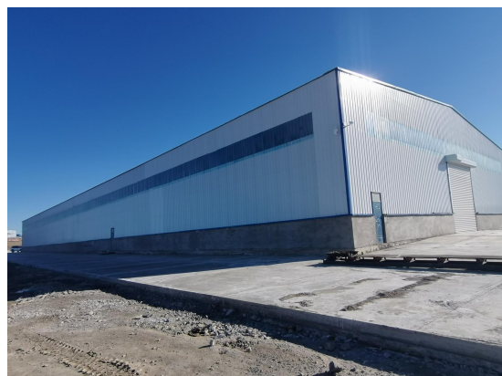
制砖生产车间外部
