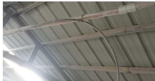
破碎车间降尘喷淋管线
