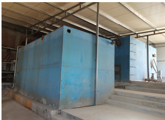
选厂废水沉淀池
