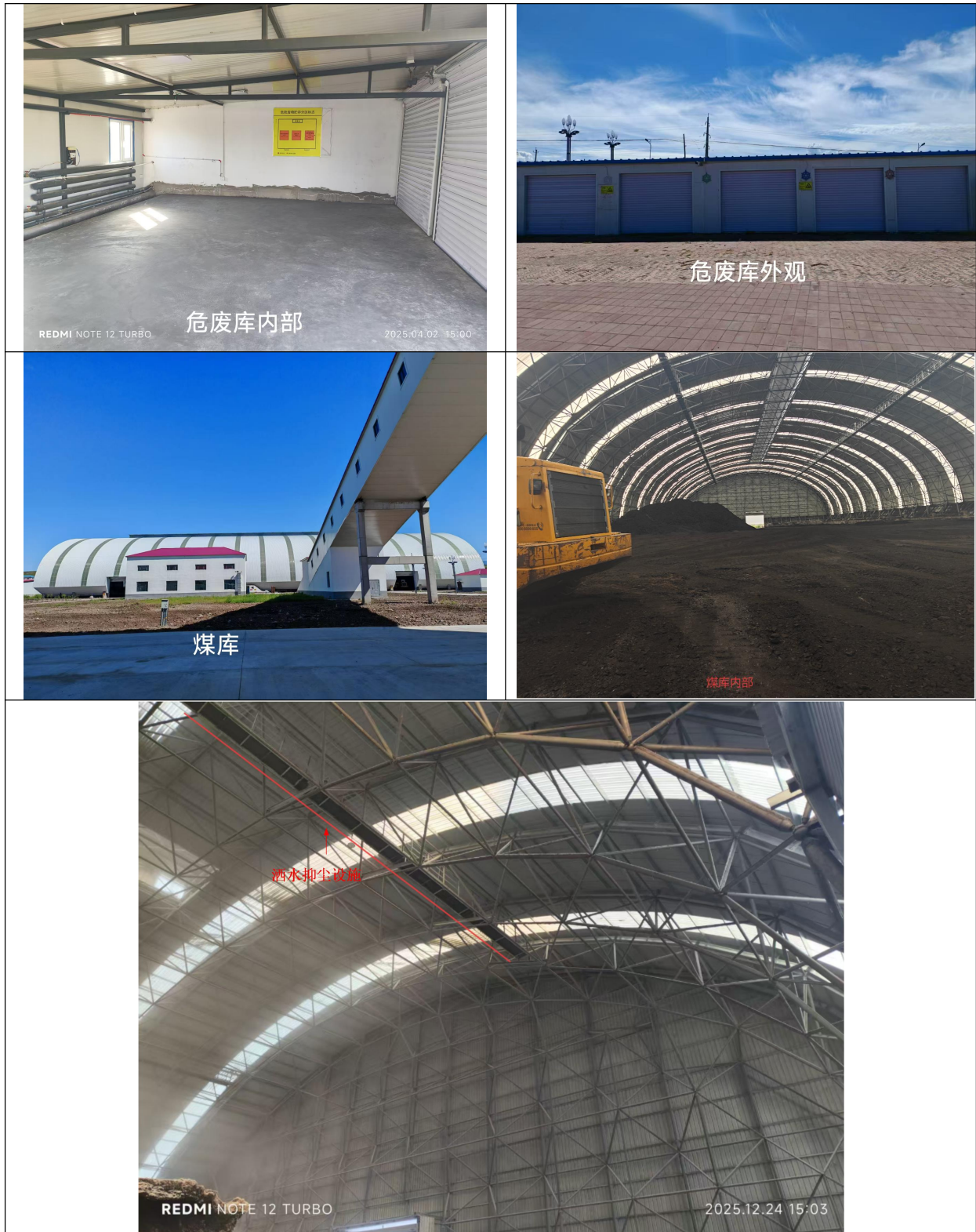
图 3.2-1 厂区现有工程照片
