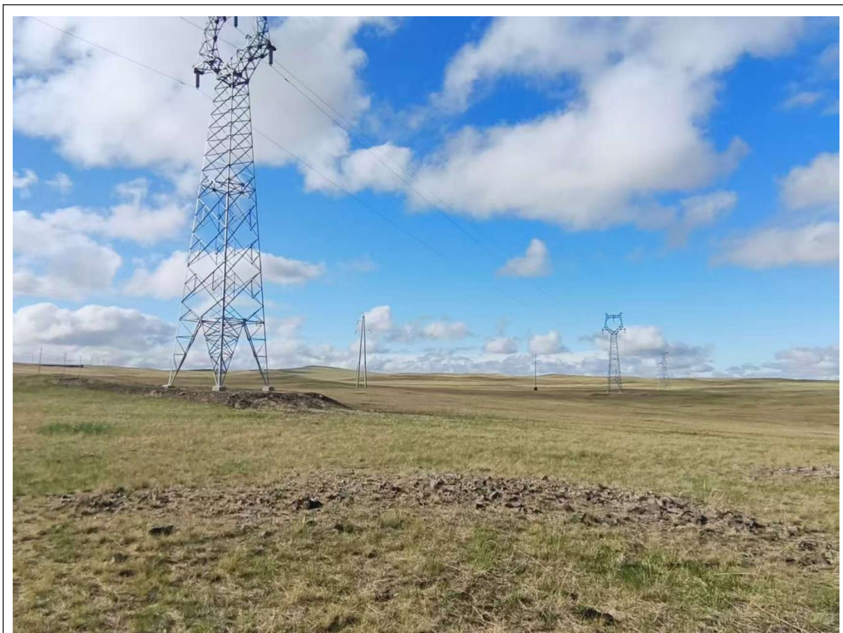
金甲 1 线拆除塔基现状照片
